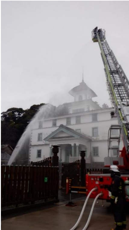
はしご車・放水銃からの放水
