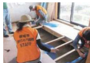
床下養生作業
