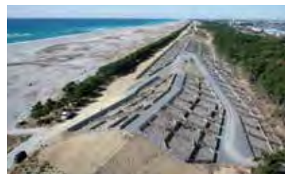
海岸堤防 (令和5年3月撮影)
