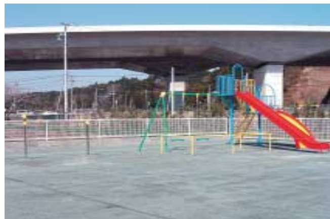
遊具が設置された公園
