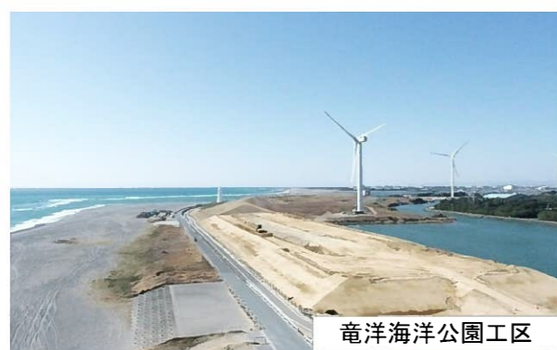
海岸防潮堤の現場状況 令和3年2月末
