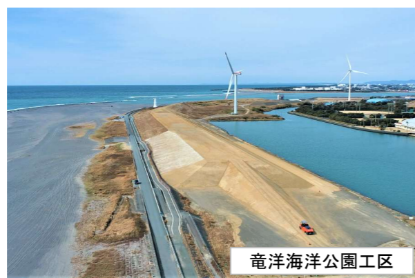
海岸防潮堤の現場状況 令和4年3月末
