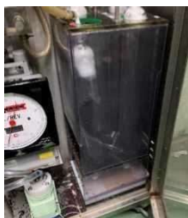
写真1 カラムの設置状況
