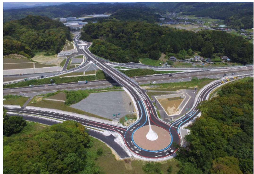
下り線側 南から北を望む
