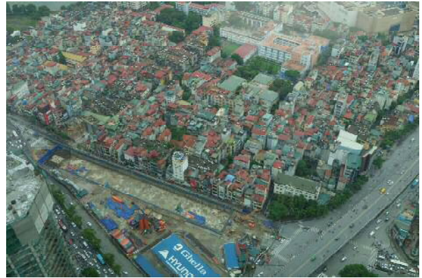
現在地下鉄の駅を建設中だそうです
