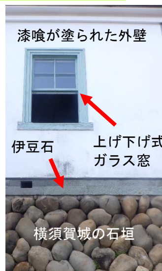
旧見付学校の外壁
