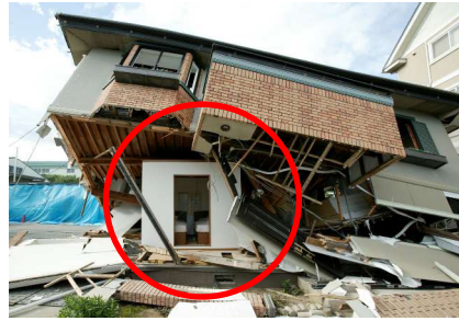
倒壊実験後の耐震シェルター
