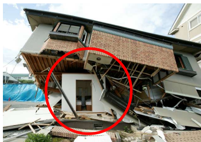
倒壊実験後の耐震シェルター
