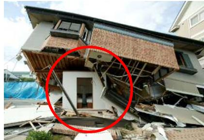
倒壊実験後の耐震シェルター
