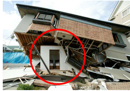
倒壊実験後の耐震シェルター
