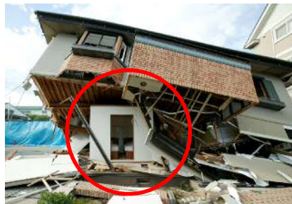
倒壊実験後の耐震シェルター
