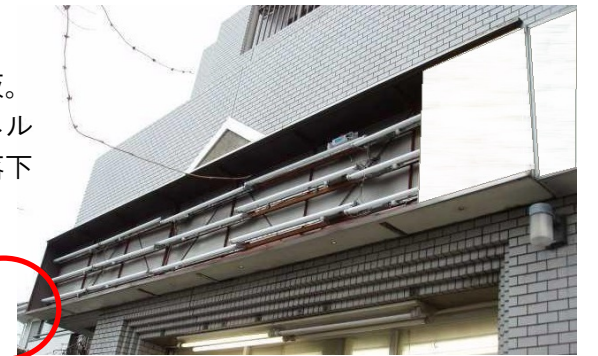
←パネルの変形、ズレ、破損の他、パネルの押さえ枠が変形し落下する場合も。
