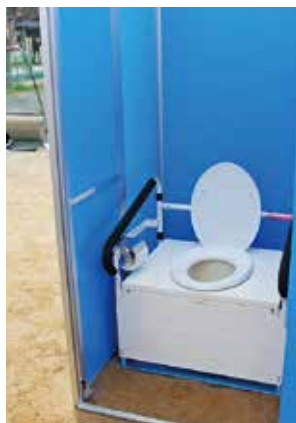
▲マンホールトイレ
