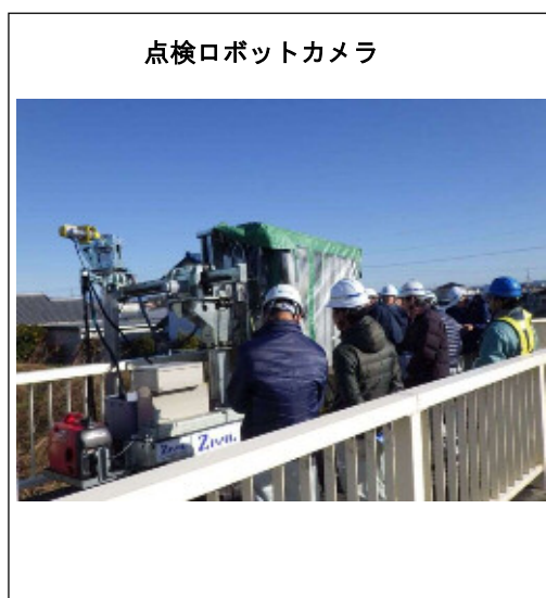
[新技術を使用した例：点検ロボットカメラ、ポールカメラ]
