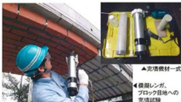
目地充填工法の例
