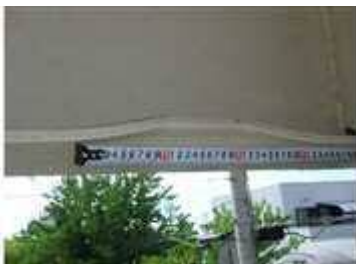
桁の変形・欠損
