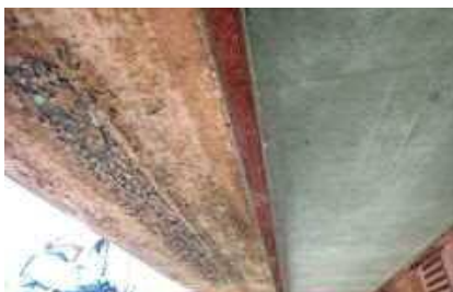
桁の腐食
