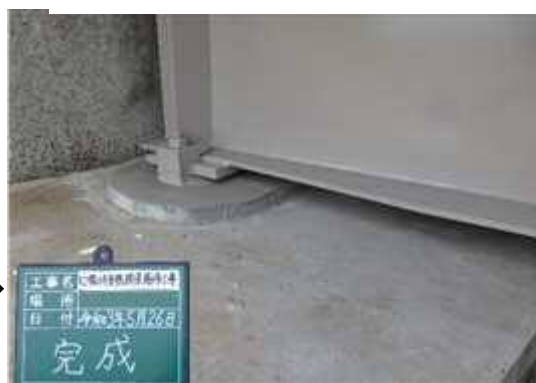
錆を落とし塗装塗り替え、断面修復
