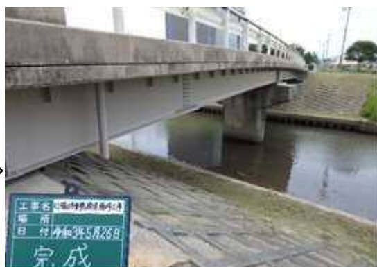
錆を落とし塗装塗り替え
