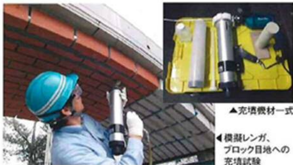
目地充填工法の例
