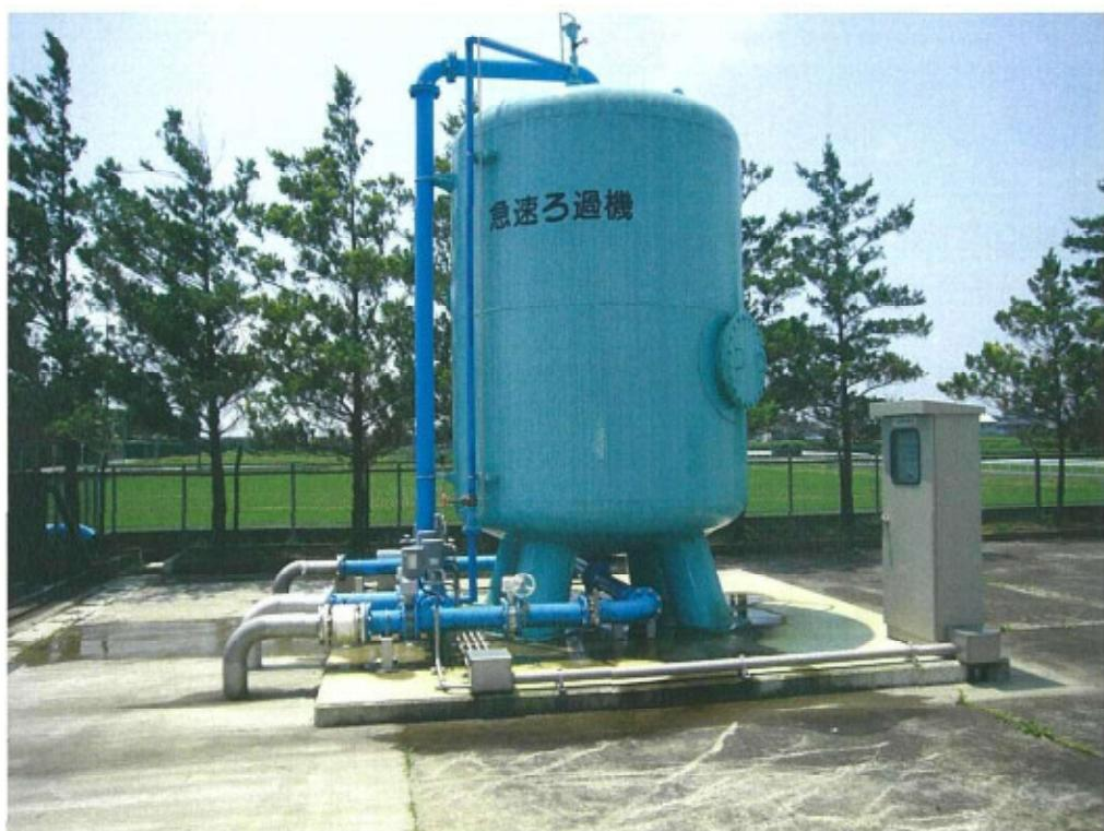
竜洋敷地配水場に設置したマンガン除去装置
