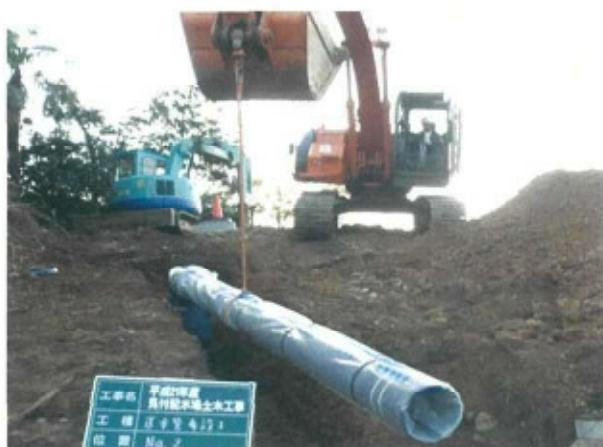
重機を使用した水道管の埋設
