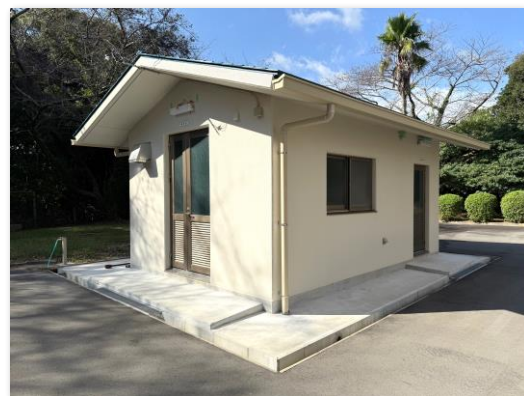
▲向笠西配水場管理棟（耐震化後）
