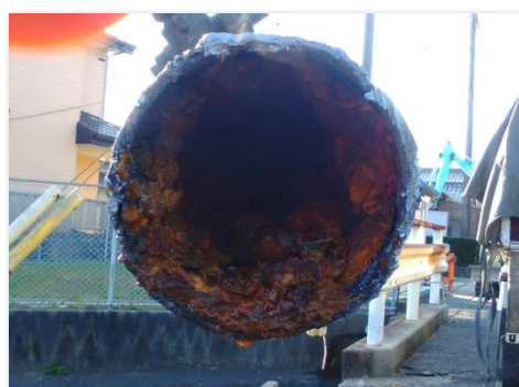
▲老朽管の撤去
