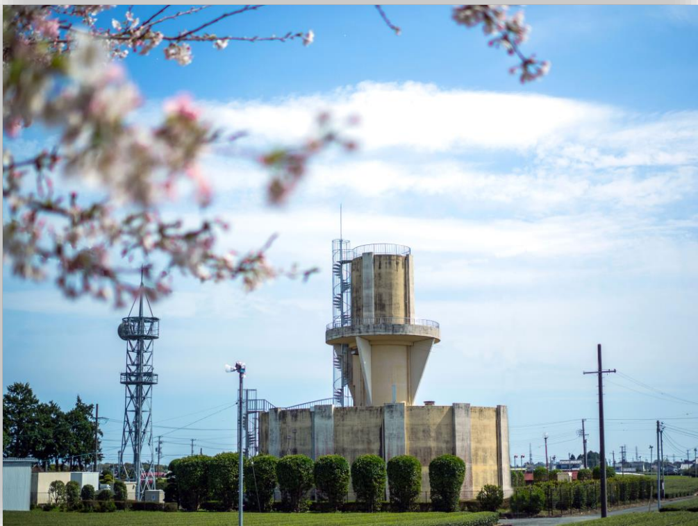
▲藤上原配水場
