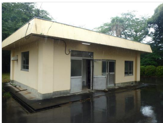
▲向笠西配水場管理棟（耐震化前）
