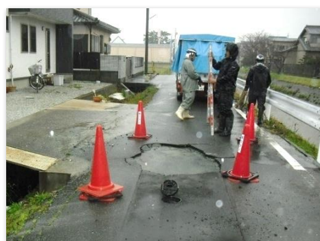
▲道路での緊急漏水修繕
