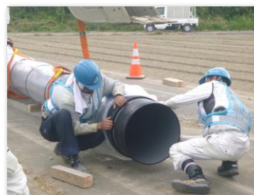
▲口径 500mm の送水管
