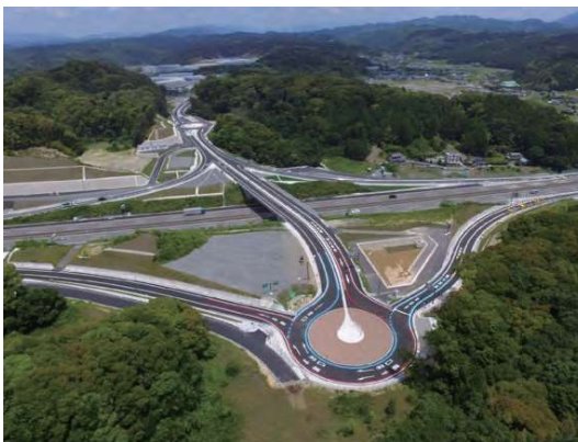
新磐田スマートインターチェンジ
