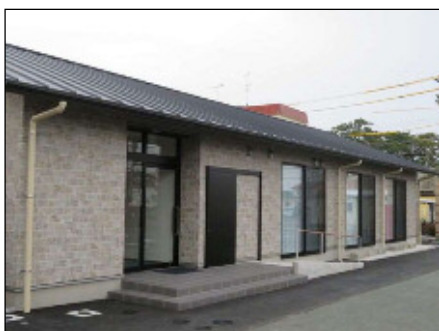
竜洋西会館の建設
