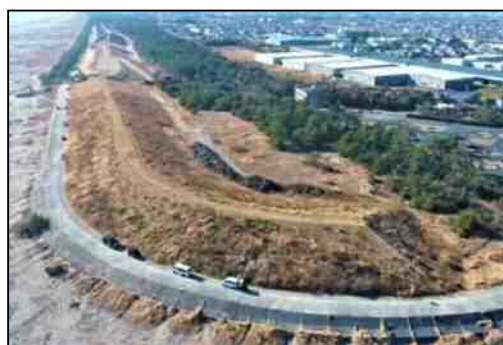
防潮堤の整備
