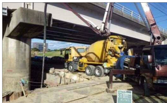
橋梁の補修・長寿命化
