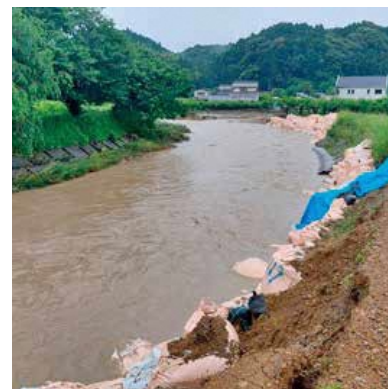
台風第2号に伴う豪雨災害直後の敷地川の様子
