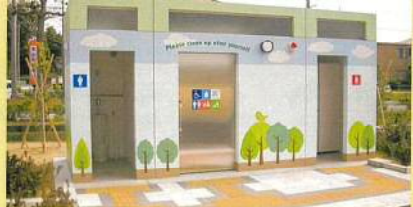
今回設置したトイレは全て、真ん中の多目的トイレの下にピットが設けてあり、災害時に汲み取りトイレとして活用できる防災トイレとなっています。
