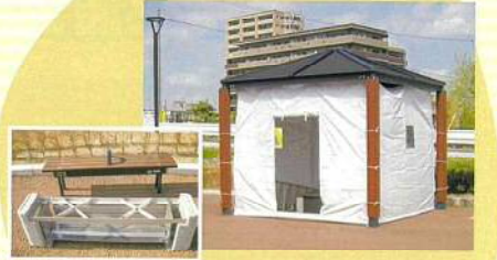
防災四阿は、側面をテント生地で覆うことができる構造となっています。また、隣接して災害時の炊き出し用に活用できるかまどベンチを設置しました。
