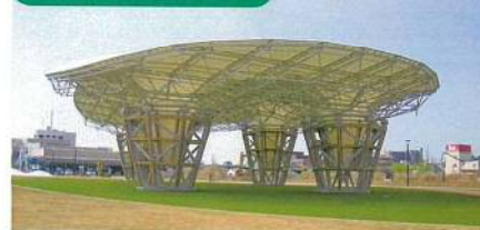
約50m×30mの広さを誇る屋根付広場は、人工芝も施されているため、憩いの場として最適です。
