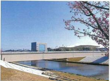
今ノ浦川の東西にある公園をつなぐFRPサンドイッチ床版を使った歩道橋です。
