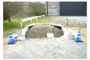
西庁舎北側に設置された土のうステーション▲
