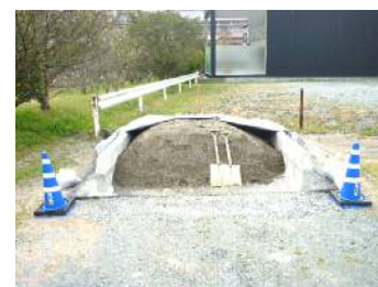
Posto de sacos de areia do lado norte do prédio oeste da prefeitura
