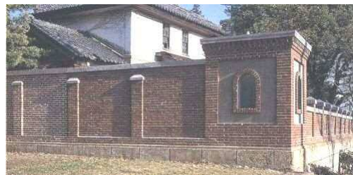
赤松家の塀：基礎部分は、コンクリートでも石でもなく、三和土ブロックです
