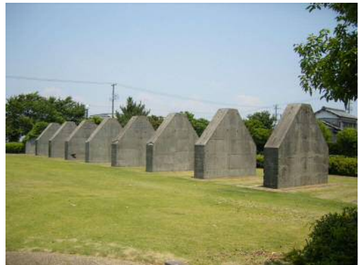
▲ 袖浦公園に残る格納庫の基礎部
