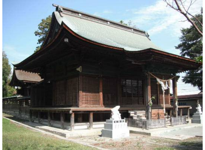
手前の拝殿から左奥の本殿を望む
