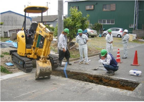
御殿・二之宮遺跡 工事立会いの様子
