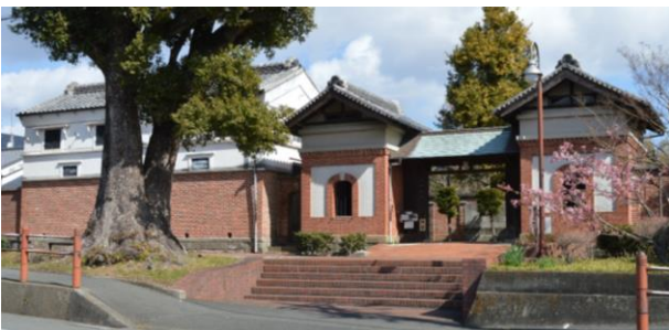
壁に煉瓦を使った土蔵と門（旧赤松家）
