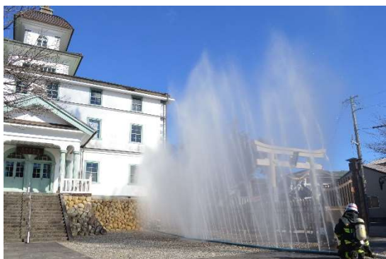
水幕ホースによる放水
