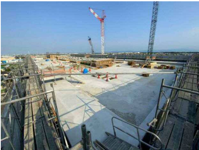
校舎棟R階
