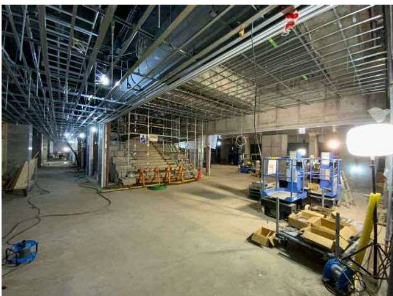
校舎棟1階南廊下
