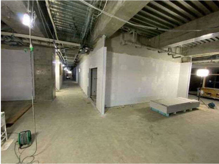
校舎棟2階北廊下
