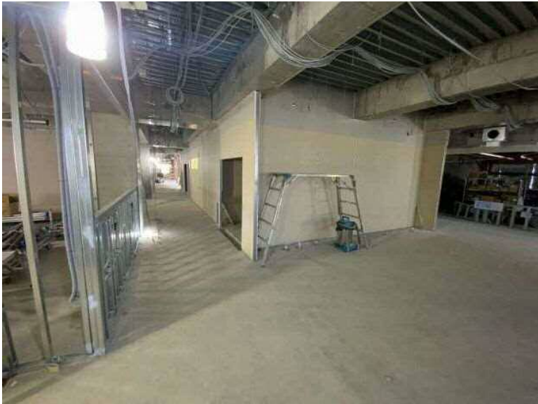
校舎棟3階北廊下
