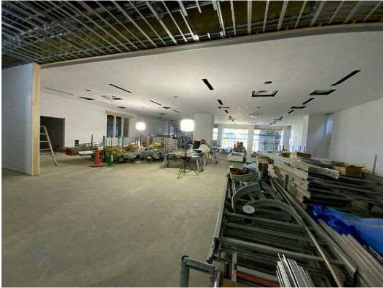
校舎棟1階ランチルーム
