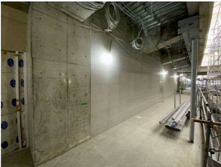
校舎棟4階北廊下
