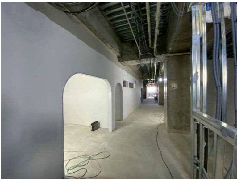
校舎棟3階北廊下
