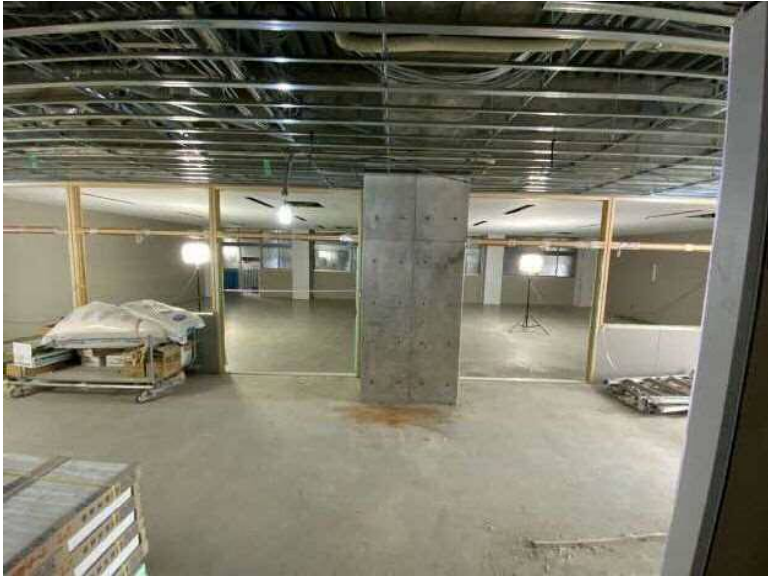
校舎棟2階普通教室
