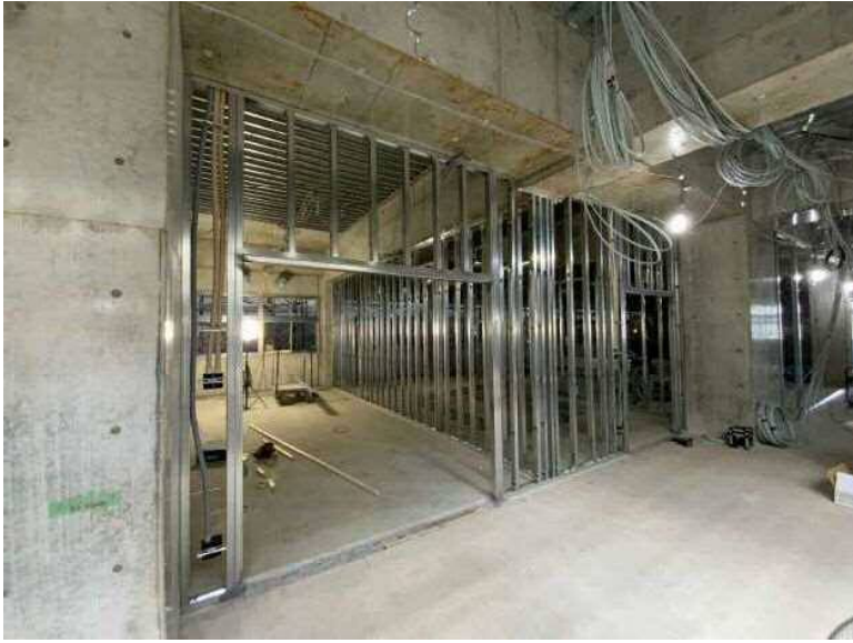
校舎棟4階美術室
