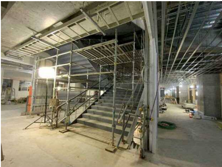
校舎棟2階階段6
