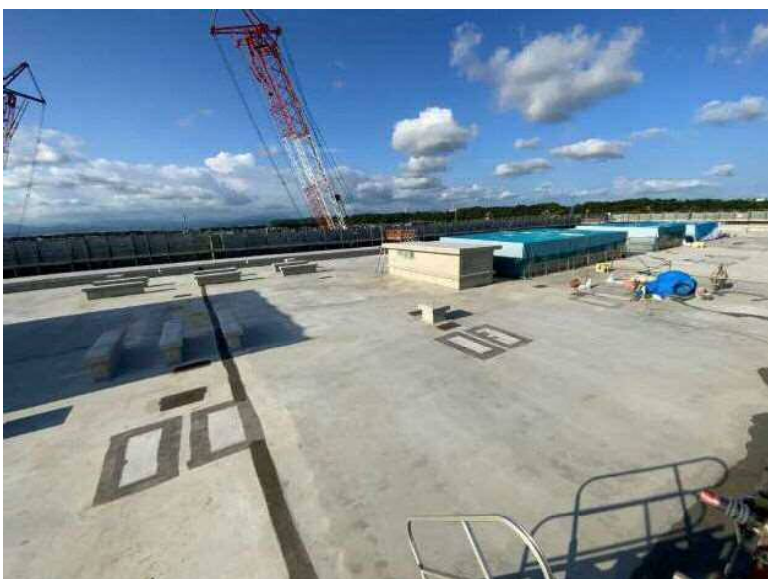
校舎棟R階(1)
