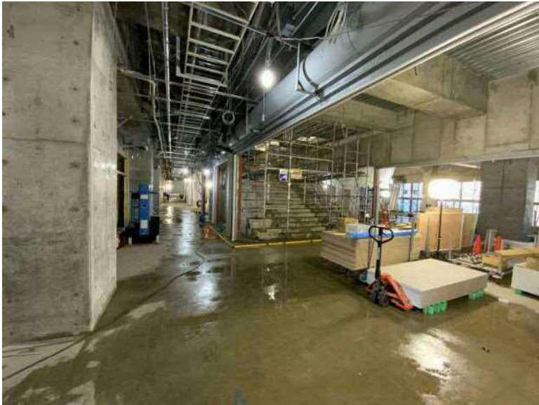
校舎棟1階南廊下
