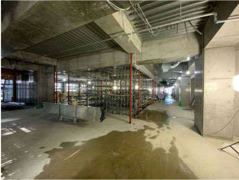
校舎棟2階南廊下
