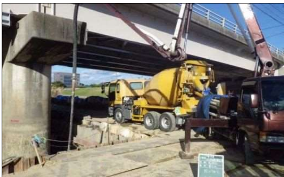
橋梁の補修・長寿命化
