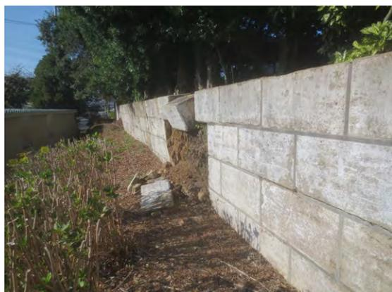
写真 103 樹木根の圧迫で崩落した三和土ブロック塀
