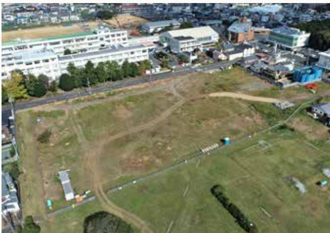
▲工事範囲航空写真（令和3年11月4日撮影）
