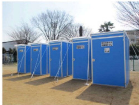
マンホールトイレ
