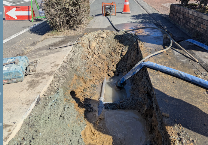
宇宙水道局を使って発見した漏水場所
