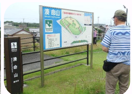
平成25年に建設された袋井市湊命山
