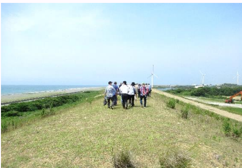
頂上から太平洋と発電風車を望む(竜洋町防潮堤)
