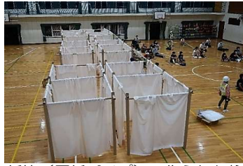
紙筒(厚紙パイプ)で作られた柱に布を被せた居住スペース見学
