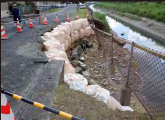
基礎部分が削られ、フェンスが宙に浮いてしまった。(大久保)
