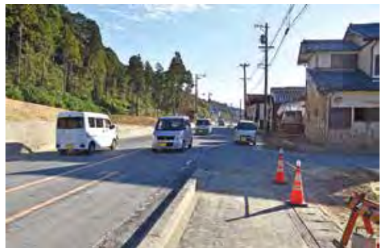
開通直後から多くの車が通行しました
