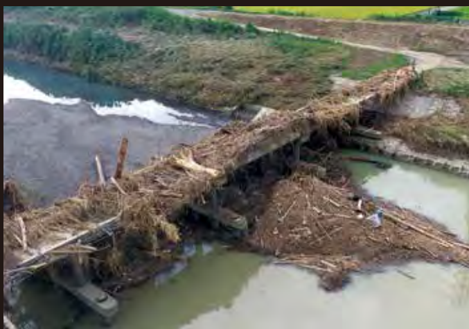
濁流に飲み込まれ、大量の流木やがれきに覆われた太田川にかかる稗原橋。(稗原)
