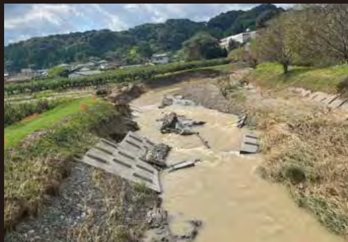
激しい濁流で護岸ブロックが流され、堤防は決壊した。(敷地川)
