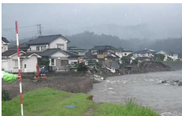
河岸侵食による家屋の倒壊(花月川)
